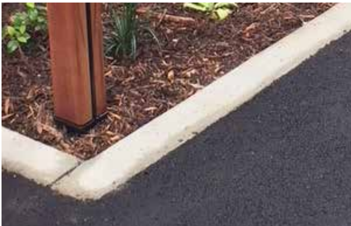
Example concrete edge
